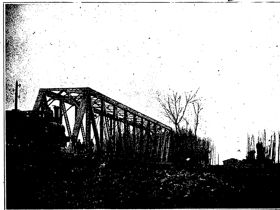
Puente sobre el río Duerna.
